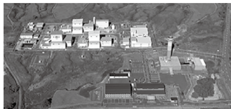
幌延深地層研究センター
